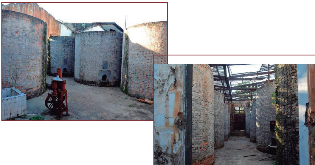
Figura 3 a- Parte da edificação desativa sem cobertura e b- estado atual de deterioração das alvenarias e da cobertura de madeira. Fonte: JR Express (2013).
